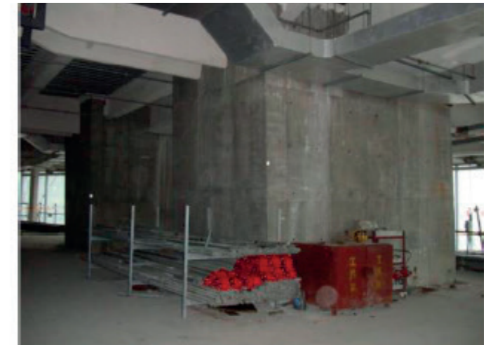
รูปที่ 13 Mega-frame และห้องเครื่องของแต่ละโซน
