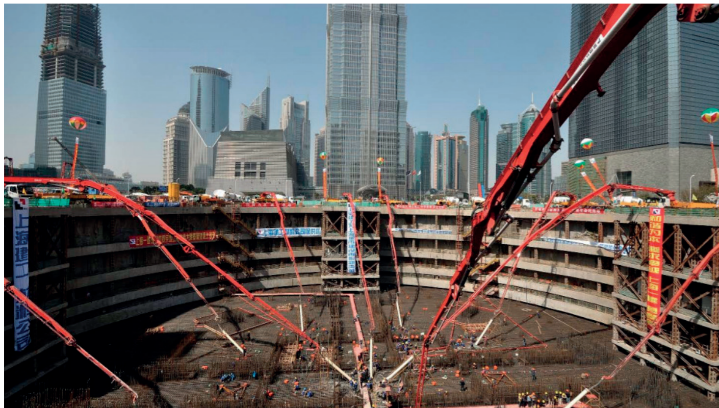
รูปที่ 10 การเทคอนกรีตฐานรากใช้เวลา 60 ชม และใช้ปูนคอนกรีต 19 ตั้ว
