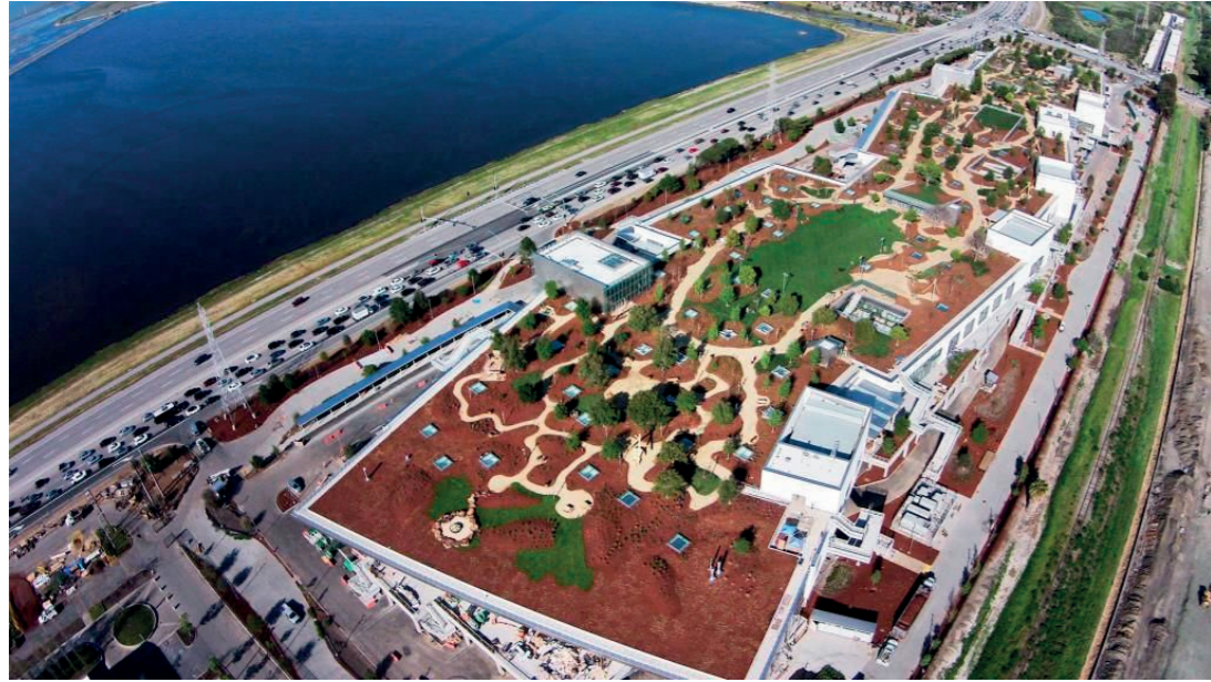
อาคารสำนักงานใหญ่แห่งใหม่ของ Facebook - MPK20 - ออกแบบโดย Frank Gehry ผ่านเกณฑ์การประเมินด้วยคะแนน 88/110 คะแนน ได้รับการรับรอง LEED Platinum
